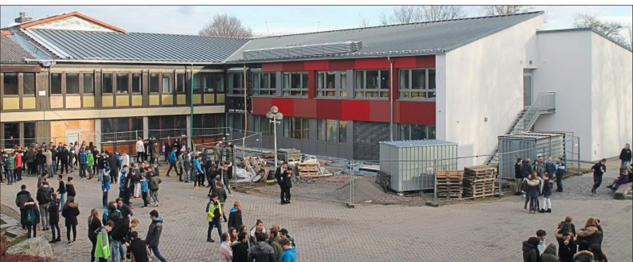
Rechts der sanierte Verwaltungstrakt, links der Zwischenbau mit Aula als künftige Baustelle, die im März begonnen wird.
